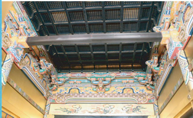
▲柱に掛かる荷重を分散するため余間に施工された鉄骨。
